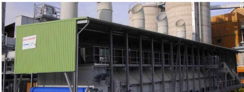
Image 4 : Sécheur basse température à bande
